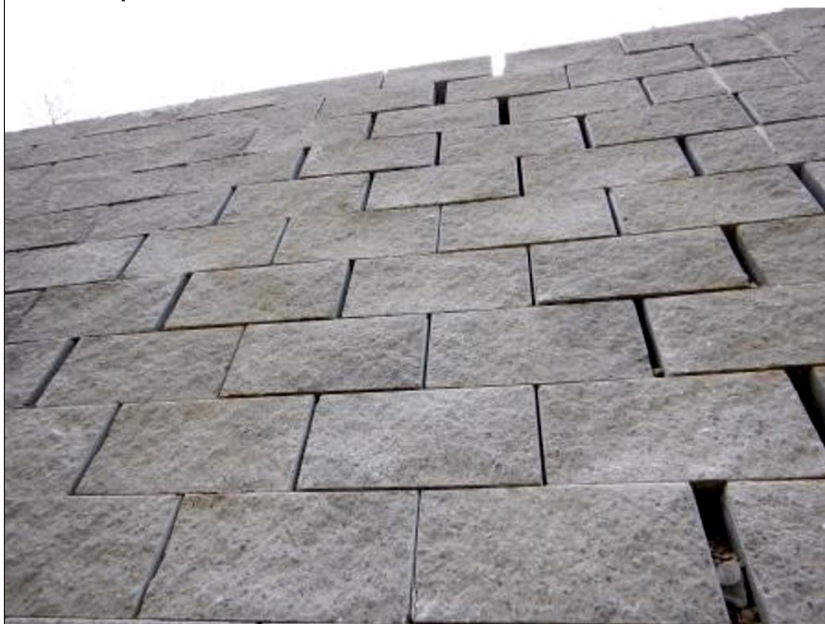
przemieszczenia muru oporowego
