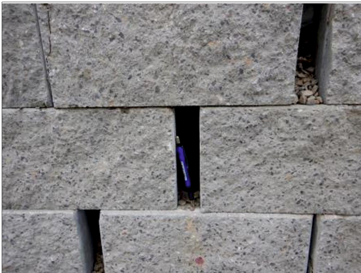
przemieszczenia muru oporowego
